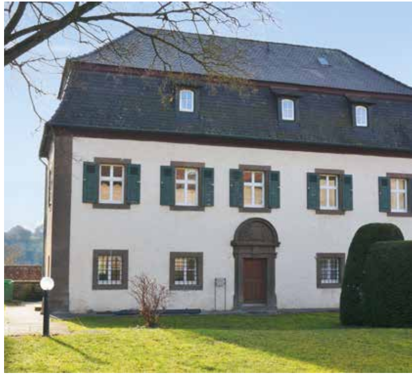
Das Kaplaneigebäude im südwestlichen Bereich der Großcomburch, in dem sechs zusätzliche Hotelzimmer mit Nasszellen eingerichtet wurden.
