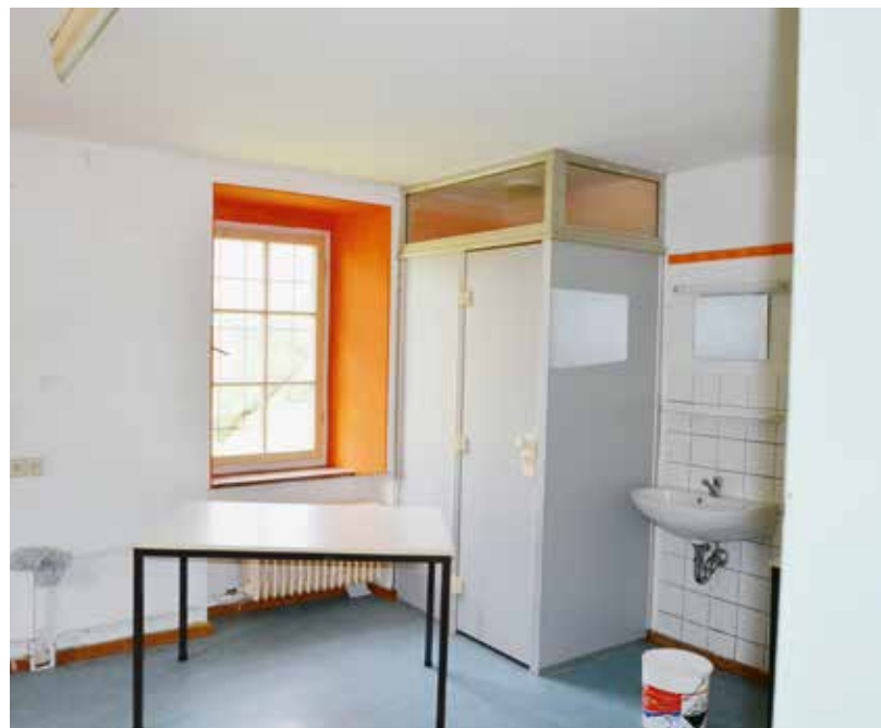
Wo bisher auf der Kleincomburch Häftlinge im offenen Vollzug untergebracht waren, könnten attraktive Hotelzimmer und Lehrgangsräume entstehen.
